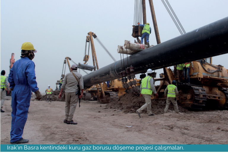
Irak'ın Basra kentindeki kuru gaz borusu döşeme projesi çalışmaları.
