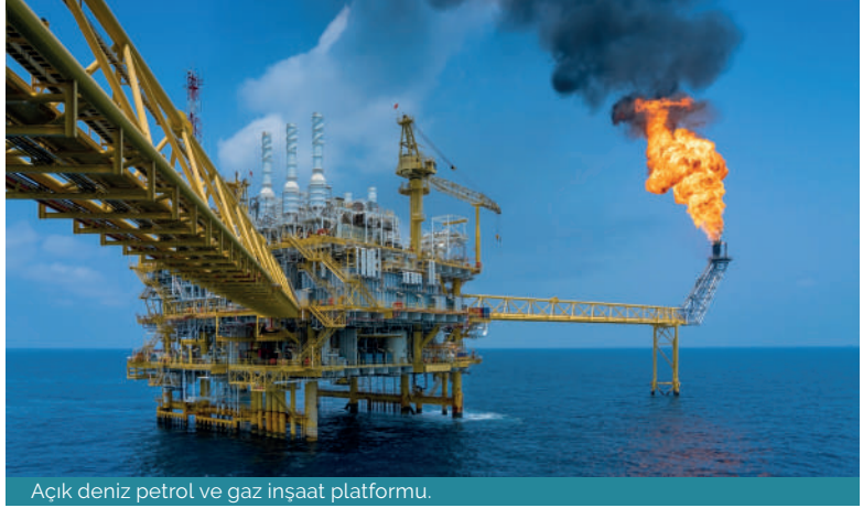
Açık deniz petrol ve gaz inşaat platformu.
