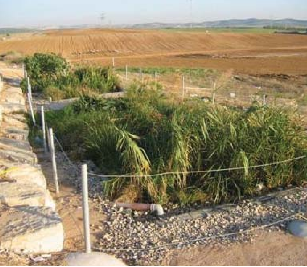
Şekil 32. Lahar Junction'da bulunan bir benzin istasyonunun atıksuyunu arıtan küçük bir yapay sulak alan havuzu (Cicelsky, 2006).
