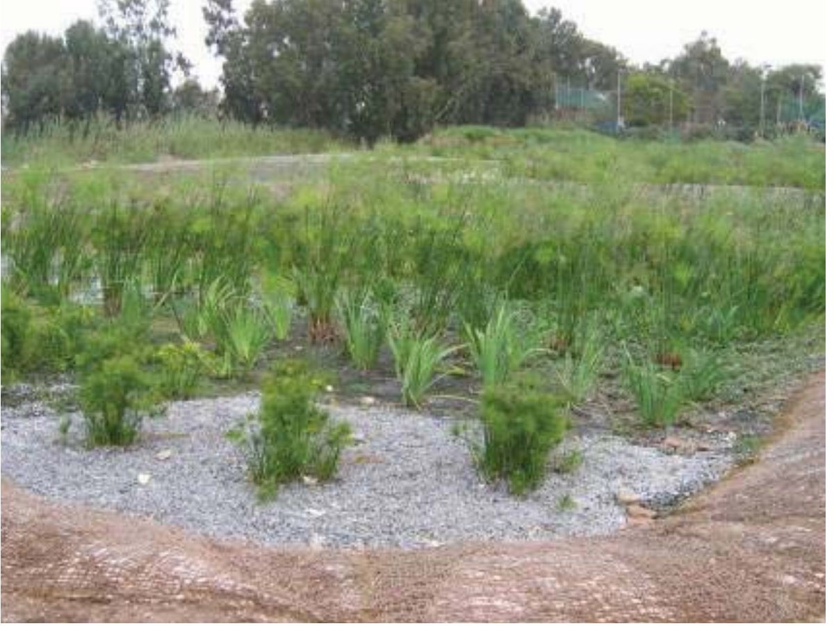
Şekil 18. Tel Aviv yakınlarında Yarkon Nehri kenarında kullanılmakta olan yüzey altı akışlı yapay sulak alan (Cicelsky, 2006).
