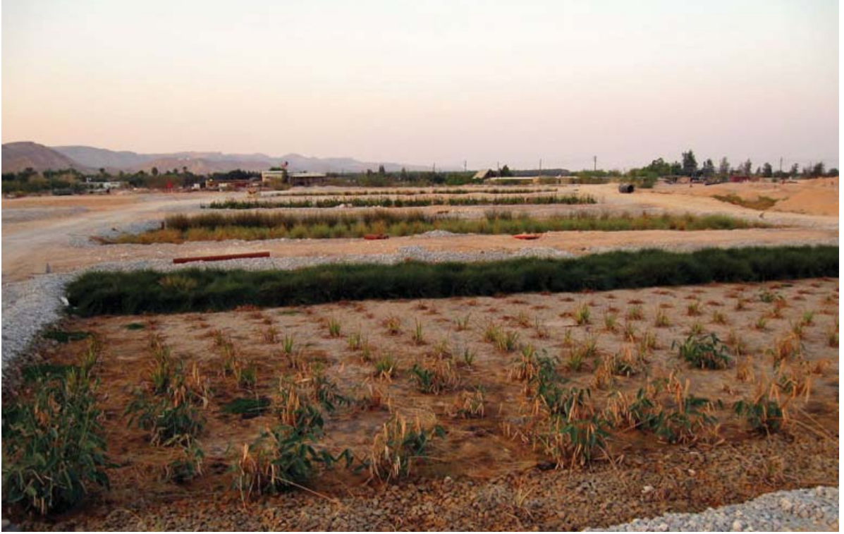
Şekil 26. Kibbutz Lotan yapay sulak alan havuzları
