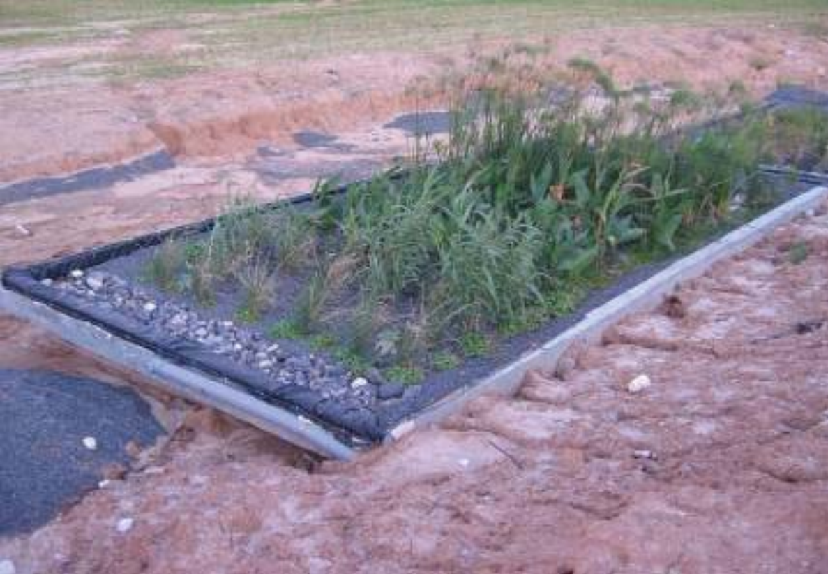
Şekil 17. Beer Sheva'da bulunan bir benzin istasyonunun tuvaletlerinin atıksuyunu arıtan bir yüzey altı akışlı yapay sulak alan sistemi (Cicelsky, 2006).
