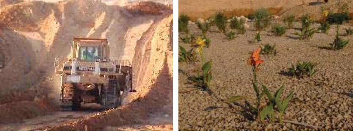
Şekil 28. Kibutz Lotan yapay sulak alanının inşaat aşaması ve yapay sulak alanda kullanılan bitkiler
