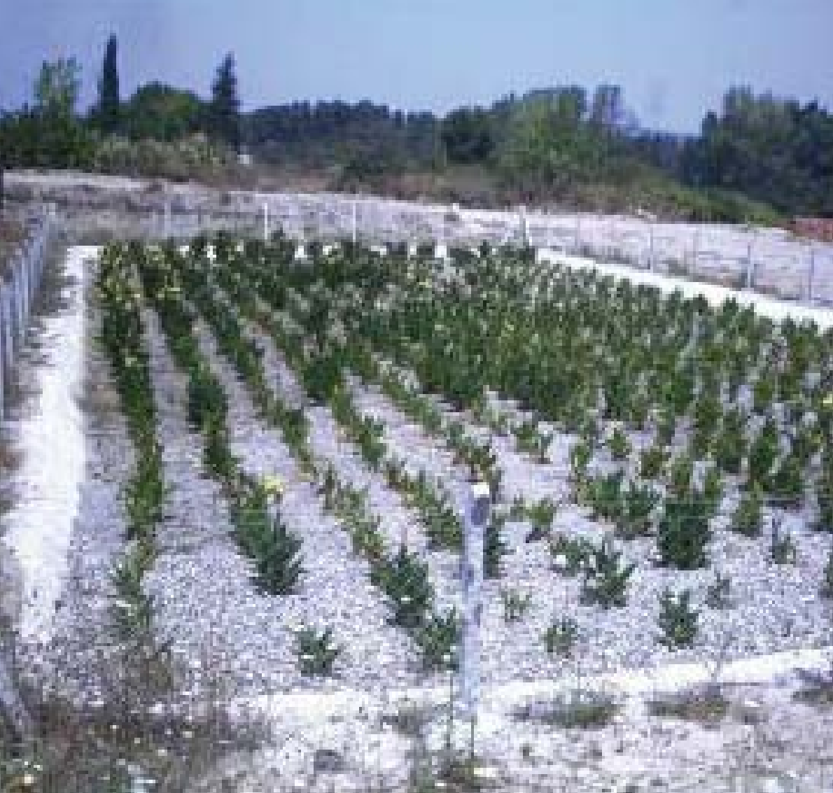
Şekil 10. Kayseri'de yüzeyaltı akışlı yapay sulak alan (Foto: Ebru Yıldız, 2009)
